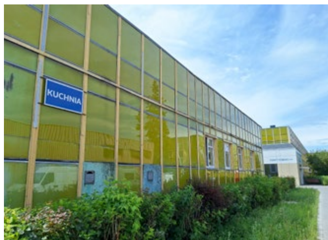
W miejscu starej kuchni powstanie sześciokondygnacyjny pawilon szpitalny
